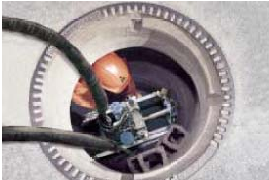
Bild 22: GrundoSchachtbohrgerät (Tracto-Technik, Lennestadt)
