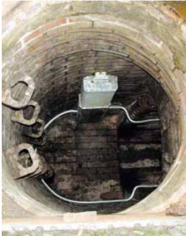
Bild 7: Beispiel für einen Schachteinbau Fig.7: Example of manhole installation (Foto: Corning)
