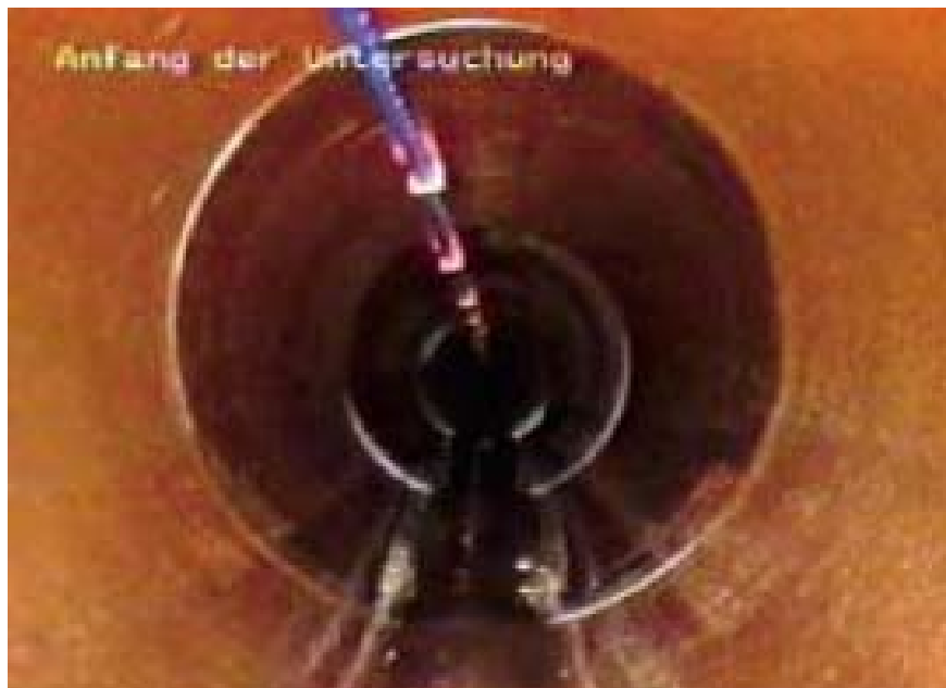
Abb. 2 Kabelverlegung im Bohr und Dübelverfahren (Foto: RCC)
